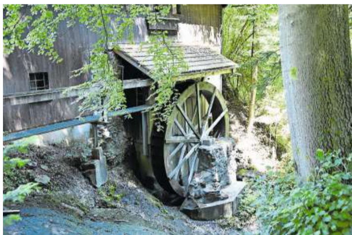
Das Wasserrad der Hätschberg-Säge misst fünf Meter im Durchmesser.
