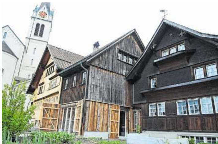
Aussenansicht des teilerneuterten Doppelhauses am Eichelstock.
